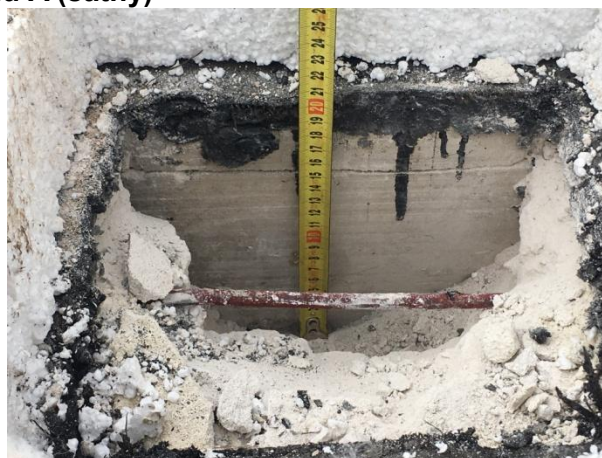
Obr. 3 Detail skladby střešního pláště pavilonu
