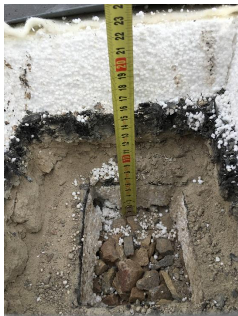
Obr. 6 Detail skladby střešního pláště pavilonu
